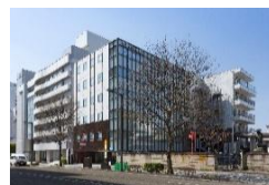
㉖ 支倉メディカルビル
